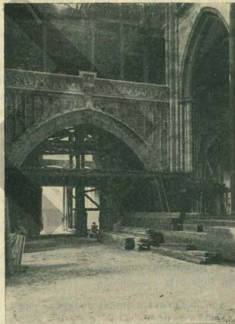
Dokončené čelo hudební kruchty.
